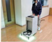
樹脂に専用の機械で光を当て硬化させます。数秒で硬化し保護性能を発揮、すぐにでも歩くことが可能です。
